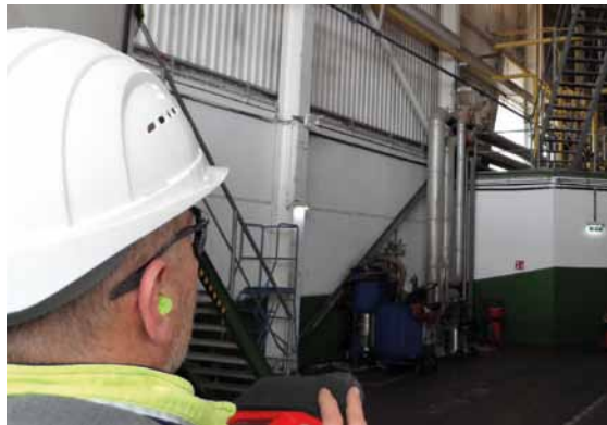
Bild 1 Überprüfung der Erdgasverrohrung aus sicherer Distanz
