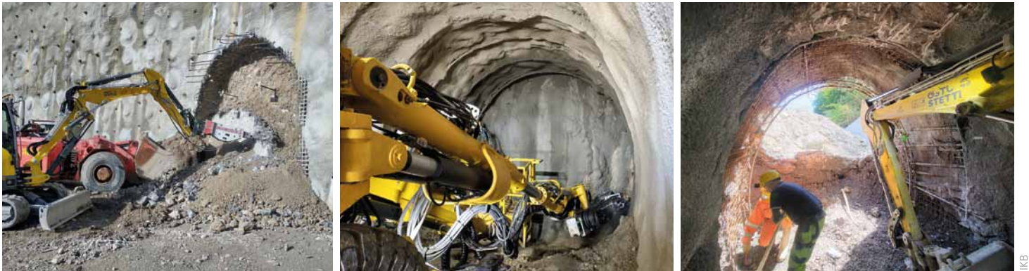
Vortriebsarbeiten für den Umgehungsstollen bei der Mühlauer Quelle
