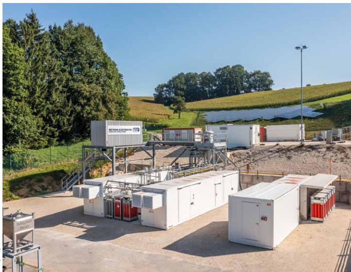
In der Modellanlage im oberösterreichischen Kremsmünster erzeugt die RAG aus Erdgas CO 2 -neutral Wasserstoff und festen Kohlenstoff.
