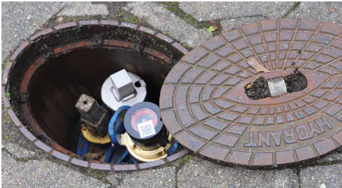
Links: Blindverschraubung mit Sensor in Straßenkappe eingebaut, zur Überwachung gegen unbefugte Benutzung. Rechts: Blindverschraubung mit Sensor
