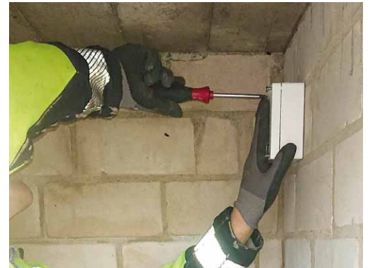
Links: Wasserzähleranlage mit Sendemodul Temperatur zur ortsunabhängigen Temperaturkontrolle. Rechts: Installation des Sendemoduls Verbrauch zur einfachen Überwachung des Wasserdurchflusses
