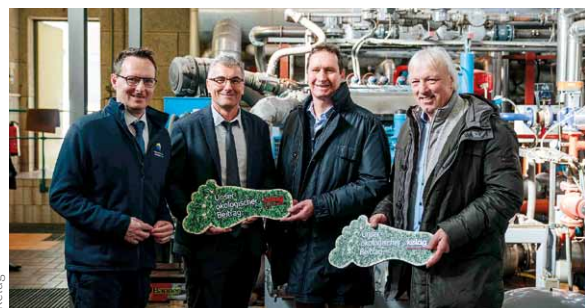
Abwärme aus der Kläranlage Spittal/Drau. V.l.n.r.: LAbg. Michael Maier (Obmann WVB Millstätter See), Betriebsleiter Herwig Ebner, Kelag-Vorstand Reinhard Draxler und KEW-Geschäftsführer Adolf Melcher
