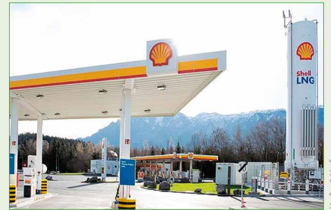
Nach St. Marienkirchen (OÖ) die zweite Shell LNG-Tankstelle in Österreich: Wals-Siezenheim in Salzburg
