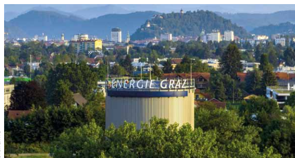
Neue Vorhaben in Graz: Neben der Nutzung von industrieller Abwärme und dem Projekt Helios sollen künftig Müll und Klärschlamm, Geothermie und weiterer Ausbau der Solarenergie als Quellen dienen
