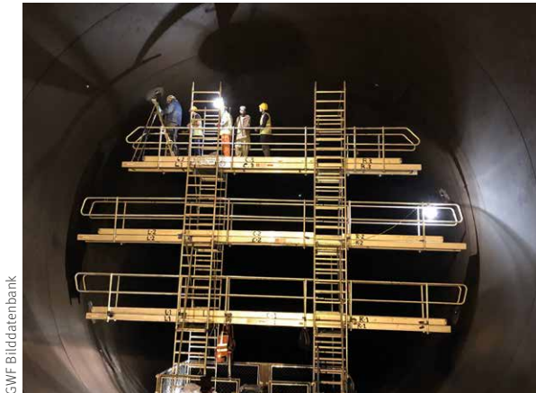
Abb. 2 Installation eines akustischen Durchflussmessgerätes in einer Wasserkraftanlage (8 Pfade)
