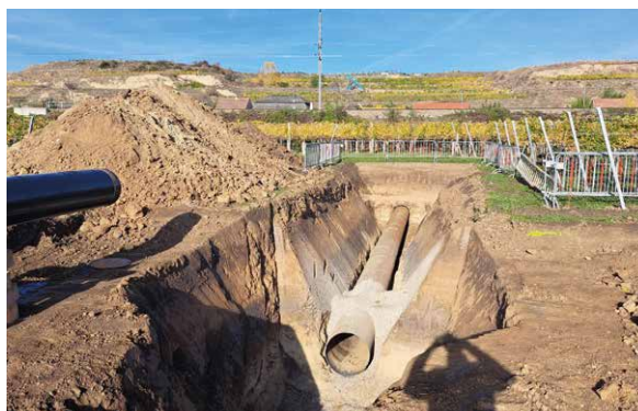
Links: Bahnlinien und die WAG mussten untertunnelt werden.
