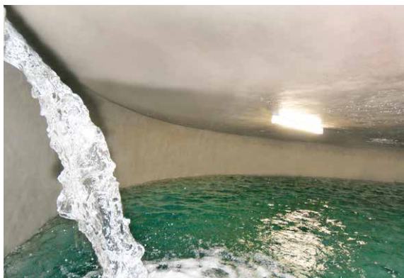
Abb. 1 Ein frisch sanierter Trinkwasserbehälter beim ersten Einlassen von Wasser
