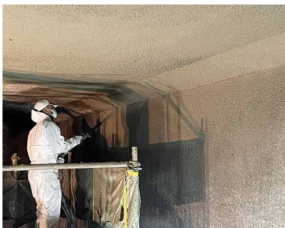
Abb. 3 Aufbringen eines mineralischen Beschichtungssystems im Nassspritzverfahren
