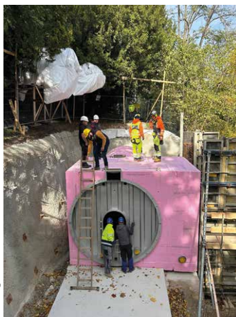
Oben: Archäologische und geologische Maßnahmen | Einflug einer Wasserkammer Unten: Schieberkammer | versetzte Fertigteile des neuen Behälters
