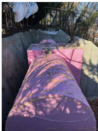
Oben: Archäologische und geologische Maßnahmen | Einflug einer Wasserkammer Unten: Schieberkammer | versetzte Fertigteile des neuen Behälters
